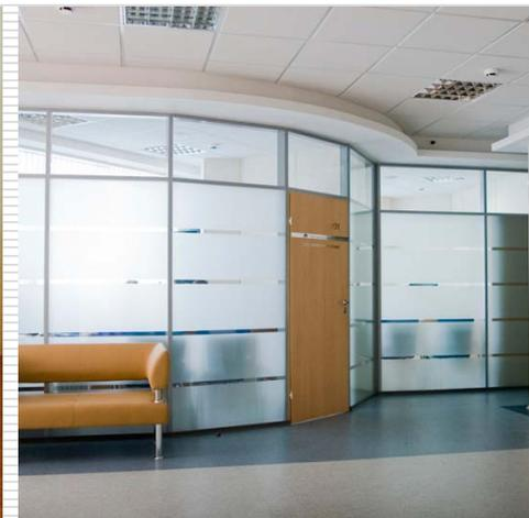
**Модульные перегородки** изготовлены на основе стального каркаса, обеспечивающего высокую жесткость конструкции и наружного алюминиевого профиля, который надежно защищает видимую часть перегородок от повреждений. При остеклении используется полированное стекло марки М1 толщиной 5 мм. Модульные перегородки позволяют легко перестраивать секции по просьбе клиентов и заменить стекло при его повреждении в процессе эксплуатации.
